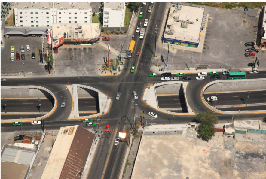
PASO A DESNIVEL REVOLUCIÓN Y JOSÉ ALVARADO Monterrey, NL
